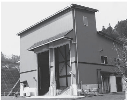
バイオマス発電所
