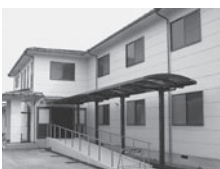
重度心身障害者通所施設ふあいん・ユ-ー現地視察
