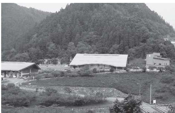
バイオマス発電所
