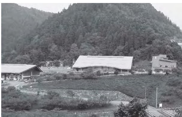
バイオマス発電所
